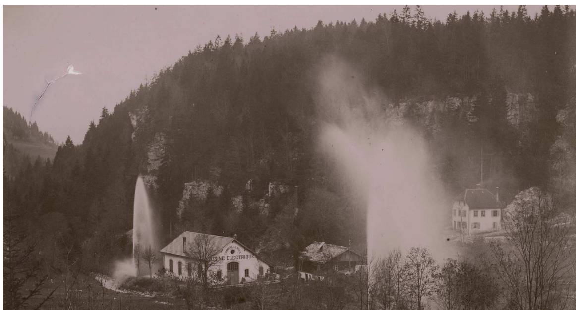
L'usine électrique de la Rançonnière
