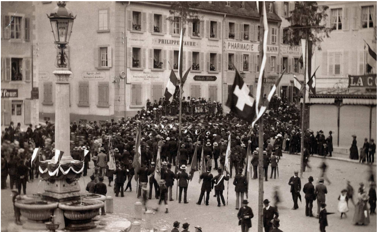
Inauguration de l'éclairage électrique sur la place du Marché au Locle
